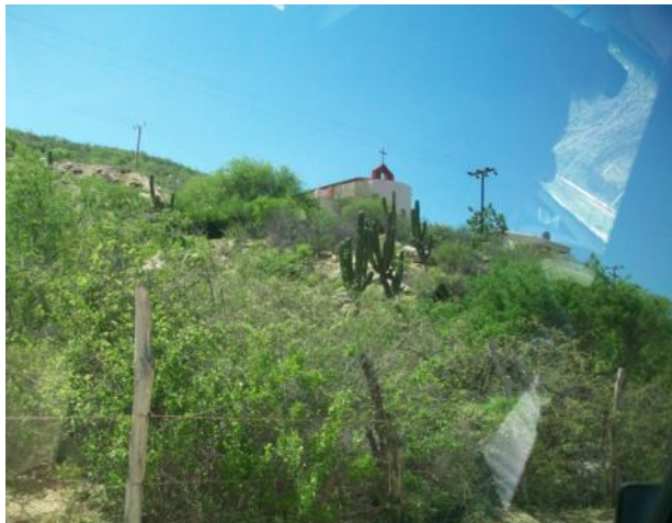
Imagen 65.: Área de peligro por desprendimientos de rocas en zona sur de área urbana de Los Barriles, Foto A. Muñoz
