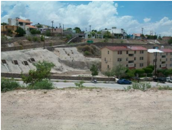
Imagen 58. Colonia INFONAVIT donde se observa tratamiento de malla y concreto para evitar derrumbes y deslizamiento. Foto P. Sámano
