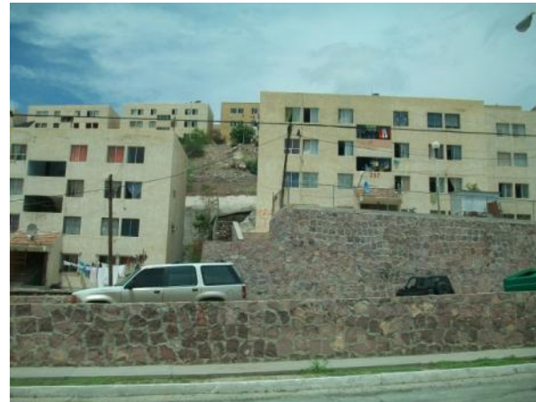
Imagen 59. En otra zona de este mismo conjunto Habitacional donde se presenta riesgo por desprendimiento de rocas. Foto P. Sámano
