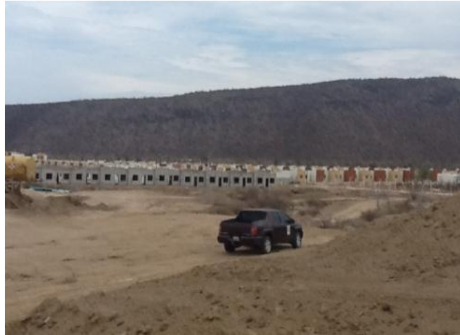
Imagen 130: Alteración de niveles topográficos y comportamiento de escurrimientos por construcción fraccionamiento Península Sur. Fotografía A.Muñoz
