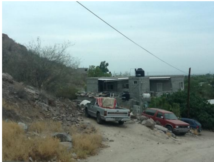
Imagen 52: Peligro por deslizamiento de laderas Col. Benito Juárez, La Paz. Foto A. Muñoz
