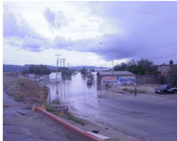
Imagen 128: Zona inundable provocada por insuficiencia de alcantarilla en la vialidad bordo de protección margen poniente del Arroyo El Calandrio
