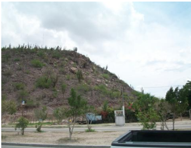
Imagen 66: La Paz, Avenida 5 de Febrero, donde se observan rodados de rocas del Cerro Atravesado y bloques a punto de desprenderse. Foto P. Sámano
