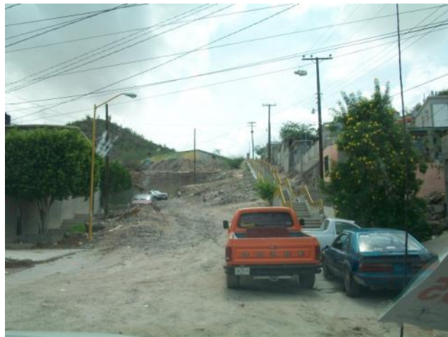
Imagen 67: La Paz, se observa desprendimiento de rocas en la callejón paralelo a la Avenida 5 de Febrero. Foto P. Sámano
