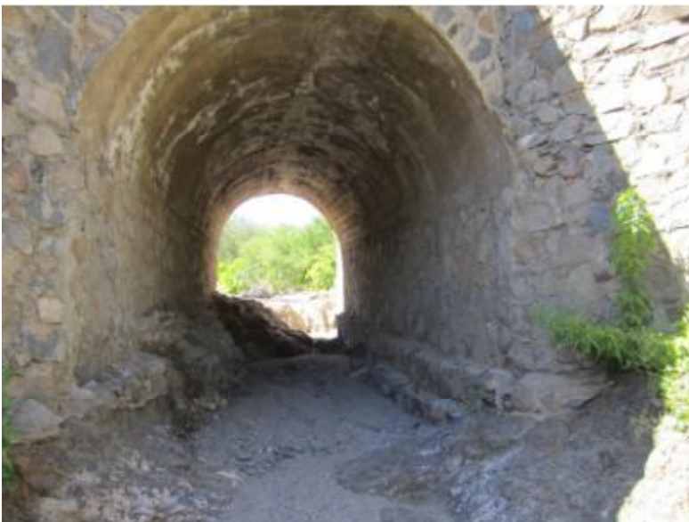
Imagen154: Alcantarilla tipo bóveda que drena los escurrimientos de la cañada Las Parras en San Antonio. Fotografía Julio Villarreal
