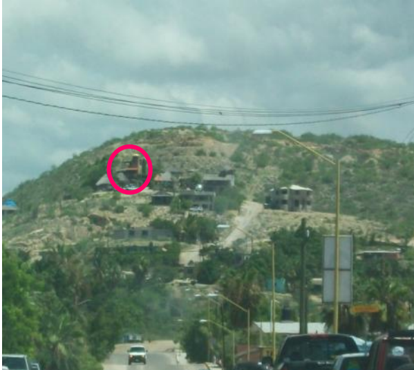
Imagen 56. Viviendas en Zona de Peligro por deslizamiento Col. San Juan al oriente de Todos Santos. Foto A. Muñoz
