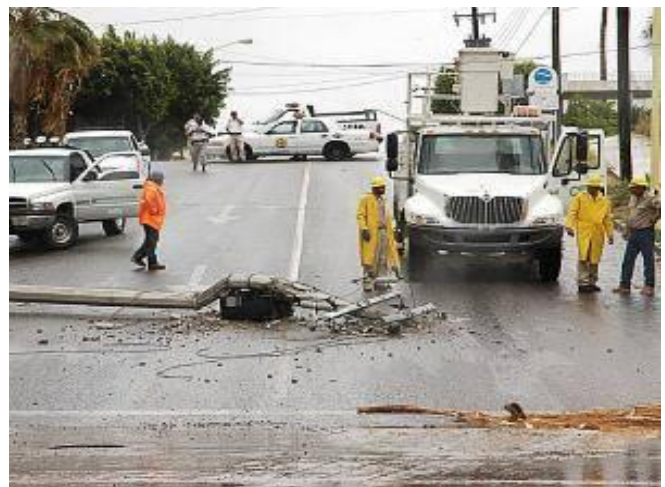
Imagen 112: Caída de postes de energía eléctrica y transformadores en centro de La Paz, después del paso del huracán Norbert, Octubre 12, 2008. Fotografía tomada de www.oem.com.mx/esto/notas
