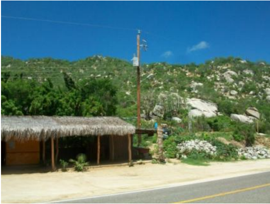
Imagen 62: Desprendimiento de bloques de roca intrusiva en la población de San Bartolo junto a la carretera transpeninsular Mex 01 .Foto A. Muñoz
