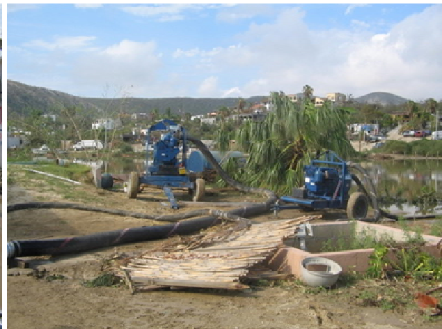
Imagen 170: Se aprecia equipo de bombeo del centro regional de atención a emergencias por parte de la CNA. Fotografía J. Villarreal
