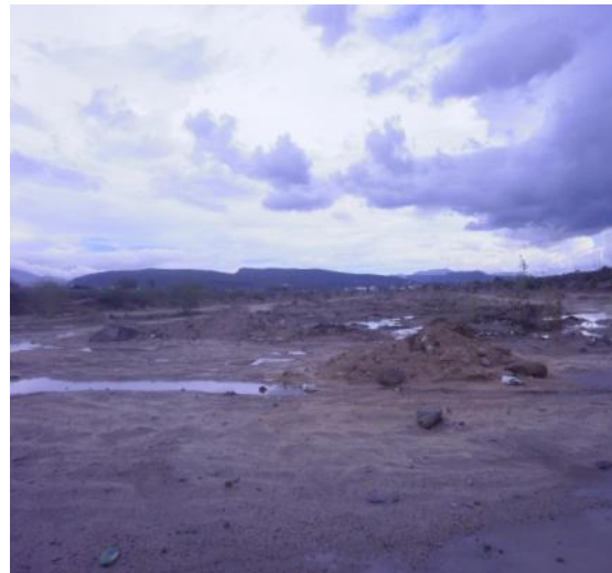
Imagen 126 : Arroyo El Calandrio, en la ciudad de La Paz, vista aguas arriba después de la avenida
