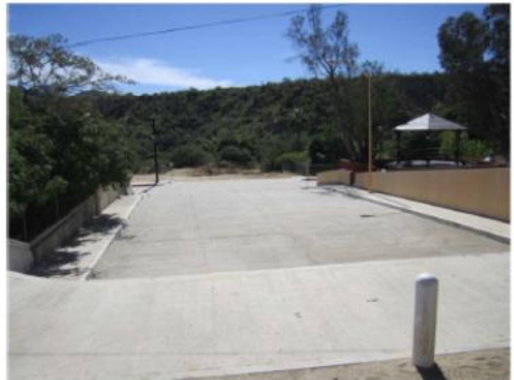
Imagen 160: Calle canal que descarga las aguas desde la carretera al arroyo San Bartolo, junto a la plaza pública. Fotografía Julio Villarreal
